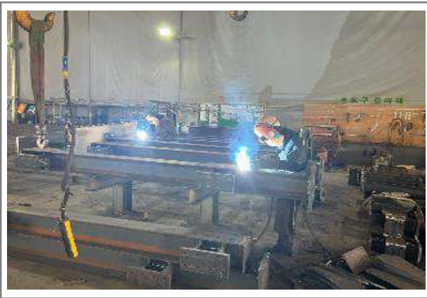
▲ Pipe Rack 제작
